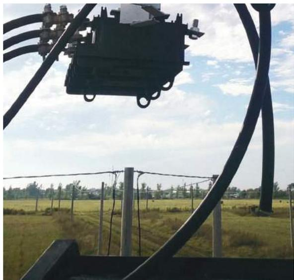
En un nuevo loteo realizado por el ente municipal, de 8 manzanas ubicadas sobre la calle Intendente Riberi, de 192 viviendas, **se construyó la Red de Baja y Media Tensión** que consistió en excavación y llenado de 48 bases de H<sup>º</sup>A<sup>º</sup> y el tendido de 3.450 mts. de cable preensamblado.
